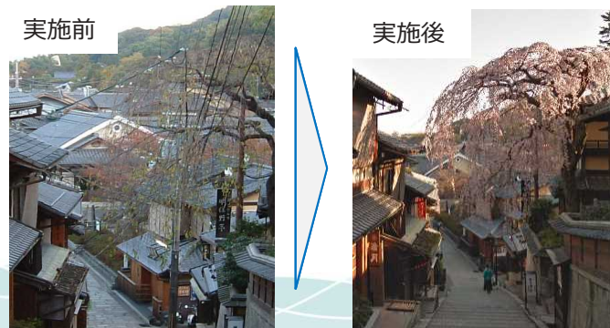
▲地中化工事の実施前と実施後
