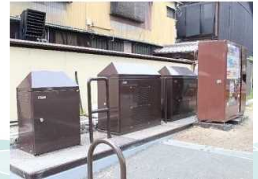
▲景観に配慮して設置された変圧器
