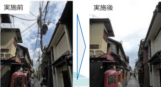
▲地中化工事の実施前と実施後
