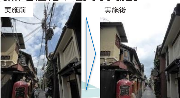
▲ 地中化工事の実施前と実施後
