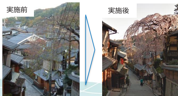
▲ 地中化工事の実施前と実施後
