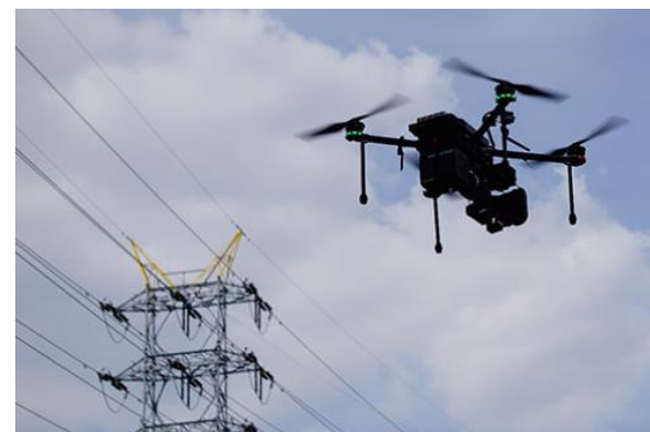
▲ドローン技術を活用した設備点検
