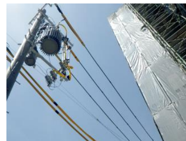
▲ 防護カバーの取り付け
