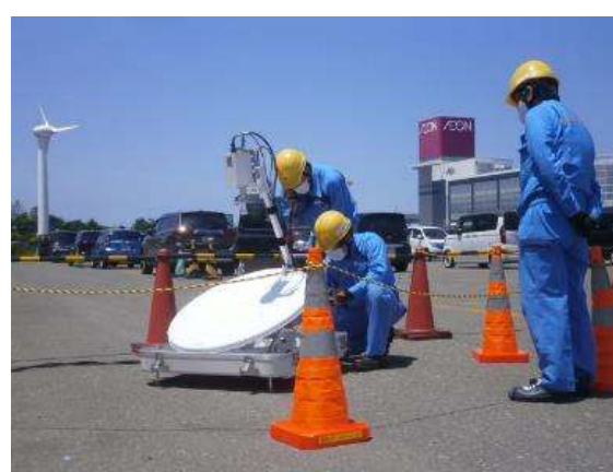
衛星回線を活用した通信回線設置
