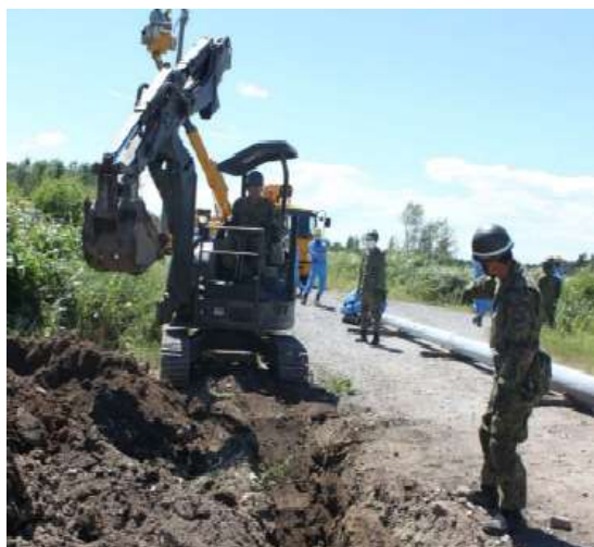
電柱建て込み場所の掘削作業
