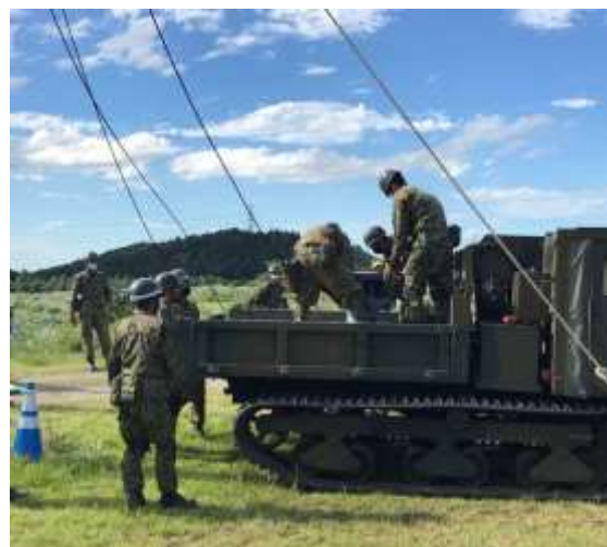
不整地運搬車による変圧器運搬
