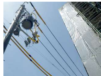
▲防護カバーの取り付け
